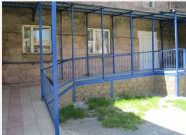
De rolstoelweg is er; aan de drie woonunits wordt gewerkt.
