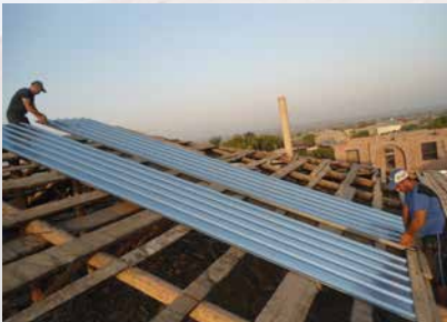
Concrete kleinschalige projecten zoals de vernieuwing van een dak.
