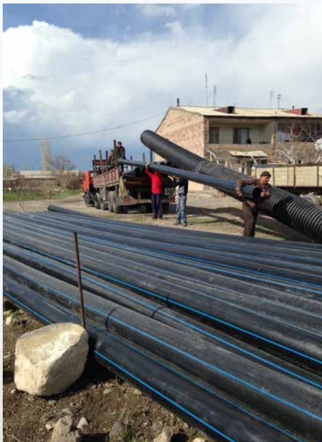
Nieuwe waterleiding in Nor Kharberd.
