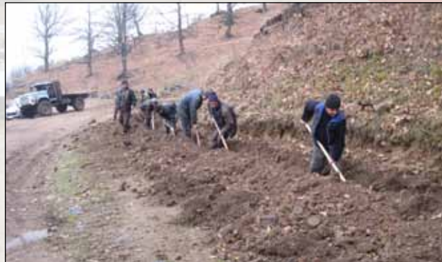
De Armeniërs steken zelf de handen uit de mouwen bij de aanleg van waterleiding.
