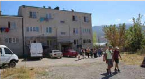
Het gebouw met de twaalf appartementen waar mensen vanuit containers konden gaan wonen.
